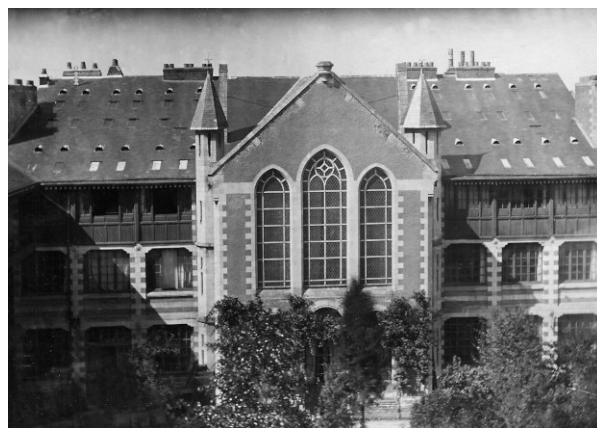
La Manufacture : halle de montage
