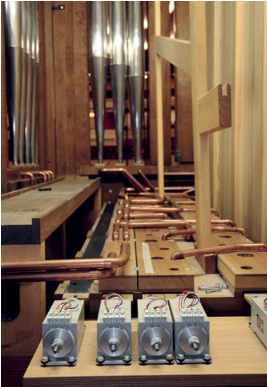
Les conduits acheminant l'air jusqu'au pied des tuyaux. De geleiders die de lucht tot aan het uiteinde van de pijpen voeren.
